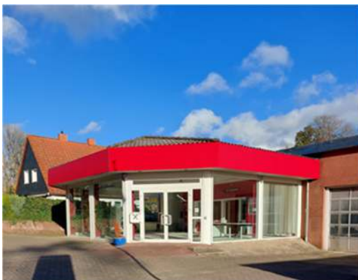
Auch im Außenbereich sind die Veränderungen am neuen Feuerwehrhaus sichtbar.
